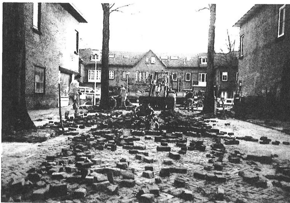
Half november 2002: de nieuwe bestrating van de Hogerbeetsstraat nadert zijn voltooi-ing.
